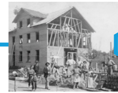
Beim Bau des Restaurants Landhaus in Lenggenwil war Mathäus Mahler noch als Angestellter dabei.
