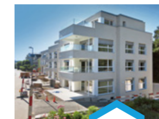
Der Bau des Mehrfamilienhaus an der Bienenstrasse 36 fiel mit dem Start des Konzepts «Komplett am Bau» zusammen.
