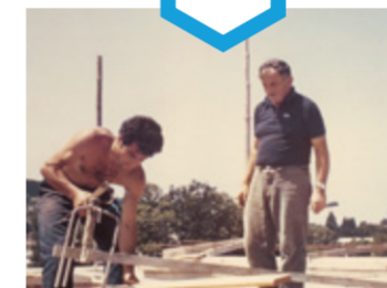
Max Mahler (stehend) im Einsatz auf der Baustelle.
